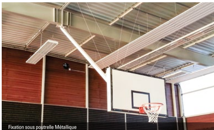
Fixation sous poutrelle Métallique
