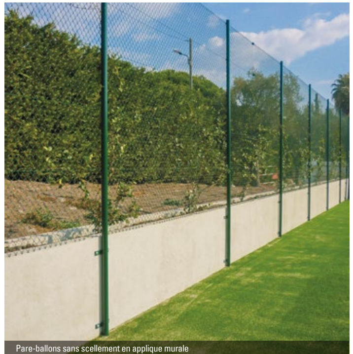
Pare-ballons sans scellement en applique murale
