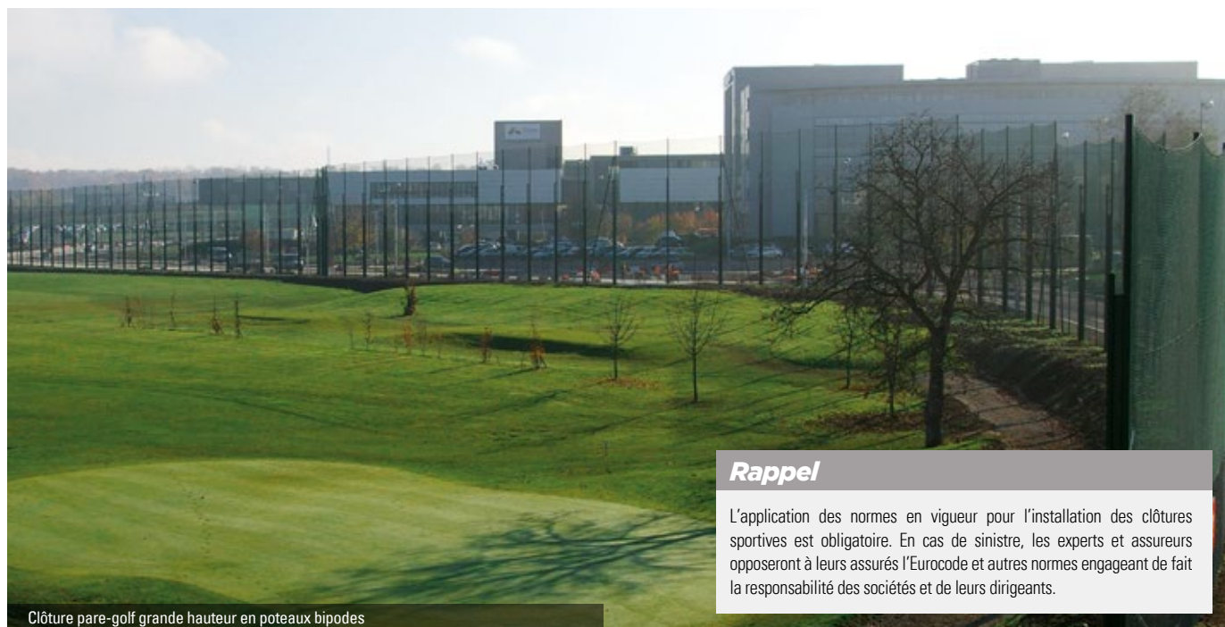
Clôture pare-golf grande hauteur en poteaux bipodes
