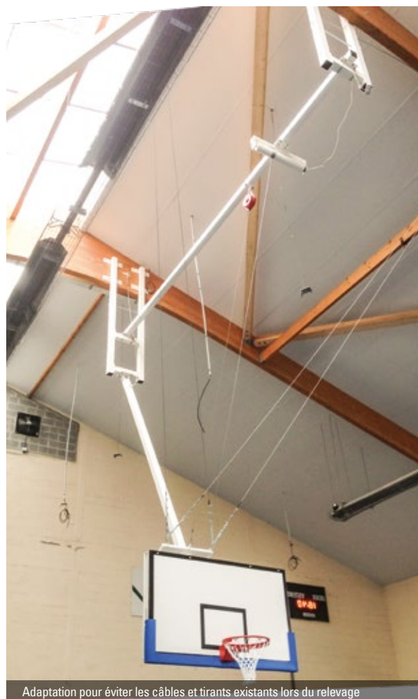
Adaptation pour éviter les câbles et tirants existants lors du relevage
