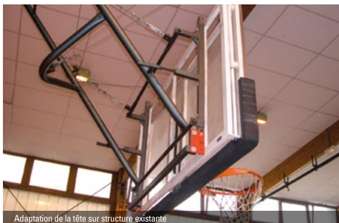
Adaptation de la tête sur structure existante
